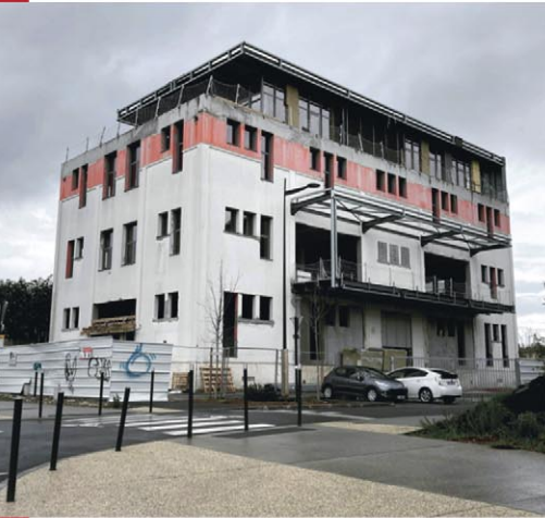
BT51 en cours de réhabilitation. Livraison été 2021
